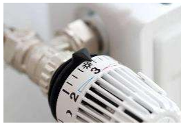
(elektronische) Thermostatköpfe montieren
