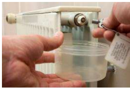
Heizkörper entlüften
