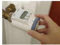
(elektronische) Thermostatköpfe montieren
