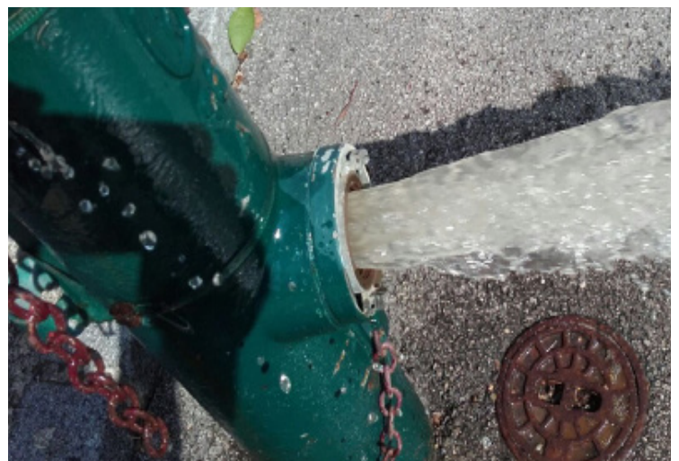
Durchspülen der Trinkwasserleitungen im Ortsgebiet
