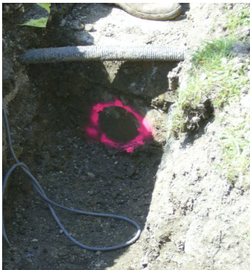
Neu verlegtes Abflussrohr am Sportplatz WC
