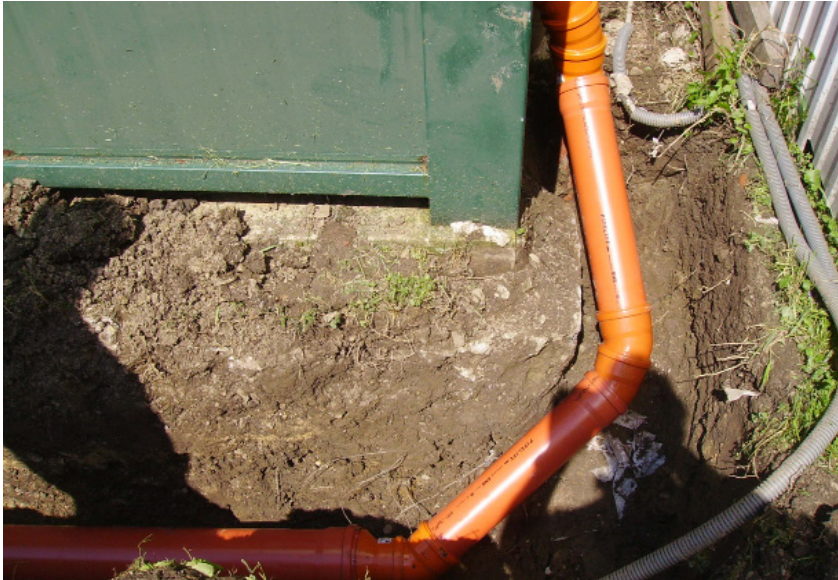
Neu verlegtes Abflussrohr am Sportplatz WC
