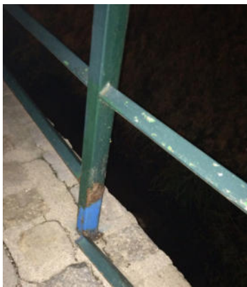
Defektes Brückengeländer
