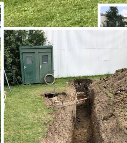
Vorbereitungen Kanalanschluss
